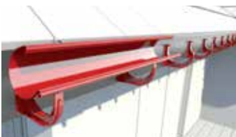
Montaż rynny w uchwyty
